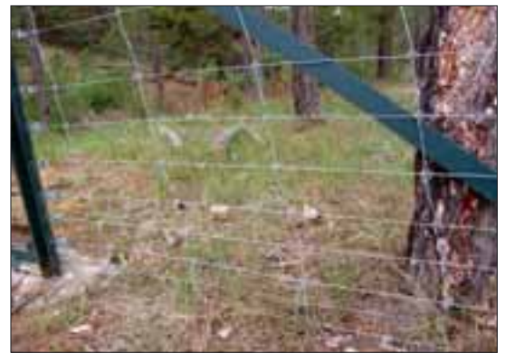
Los vallados se instalan sistemáticamente con la cuadrícula de la malla más estrecha pegada al suelo, justo al contrario de lo que debería ser, para posibilitar el paso de fauna
