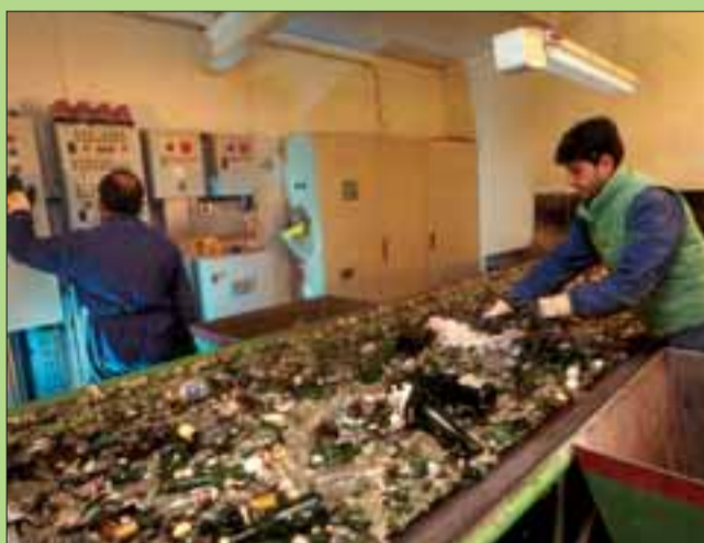
Planta de tratamiento de envases de vidrio
