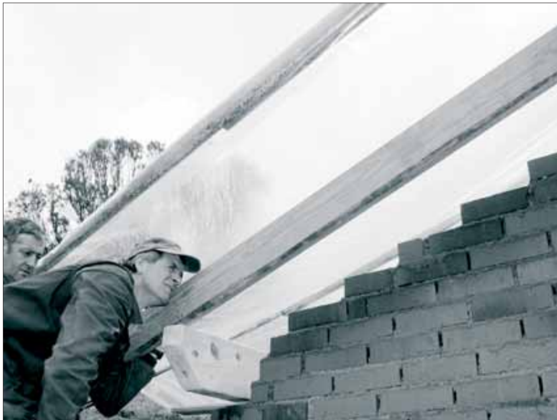
Josu Jauregi trabajando en una bioconstrucción
