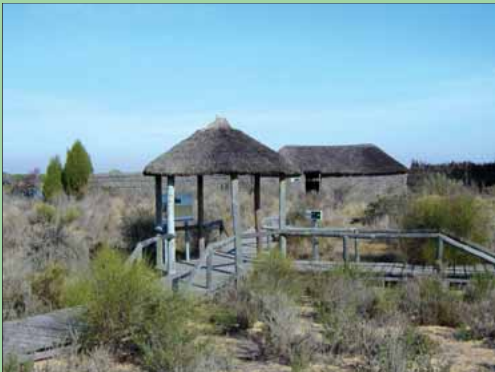
Pasarela peatonal en El Acebuche (Doñana)
